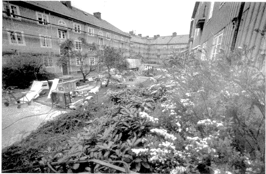
Gården under pågående renovering
