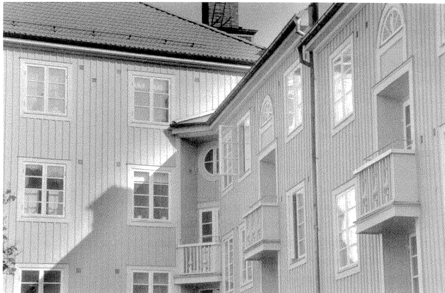
Vid ombyggnaden gjordes balkongfronterna högre och tätare. De nya spjälorna gjordes tunnare än de gamla för att markera vad som var ursprungligt.
