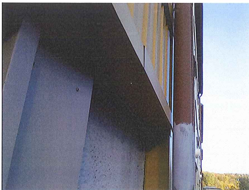
Tilläggsisolerad fasad
