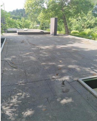
Exempel på tak, överblicksbild.
