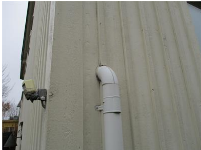
Stuprör som kommer ut i fasad
