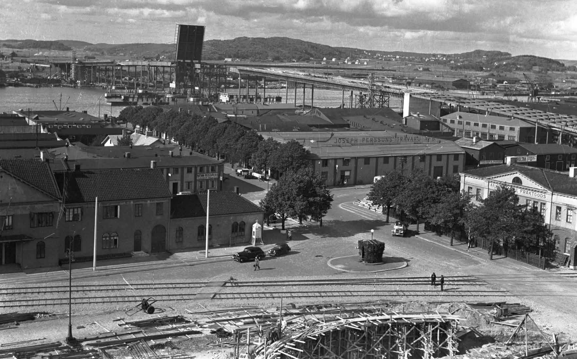
Götaälvbron byggs, oktober 1938. Vid uppförandet av bron togs stor hänsyn till befintlig bebyggelse, och nästan inga hus behövde rivas. 1935 startade markarbetena och först 1942 blev den södra uppfarten klar. Bron breddades 1958 och fick sex filer samt nya cykel- och gångbanor. Fram till 1966, då Älvsborgsbron byggdes, var den ensam om att förbinda centrala Göteborg och Hisingen. På fotot ser vi vy från Lilla Bommen. Klaffen är i gång och gjutningar pågår. På denna plats står idag den så kallade Skanskaskrapan. I dag utvecklas området återigen och ett utav målen är att göra älvstranden, med Drömmarnas kaj och Gullbergvass, mer tillgängliga. Bildkälla: Kamerareportage
